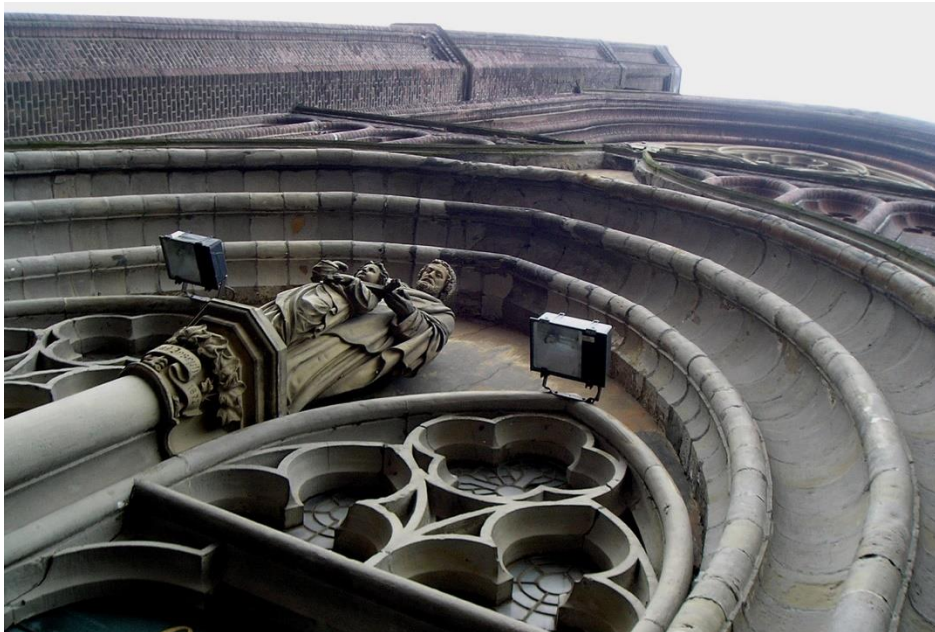
Voorgevel v.m. Sint Josephkerk / Orangerie. Foto auteur 2008.
